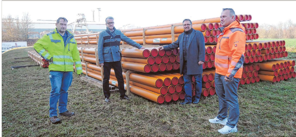
Auf dem Areal des Deichmann Logistik Centers in Dorfgütingen sind derzeit jede Menge Rohre für die neue Leitung zwischengelagert. Vor Ort informierten sich gestern Gas-Experte Andreas Kropshäuser von den Stadtwerken Feuchtwangen, Bürgermeister Patrick Ruh, Technischer Werkleiter Lothar Beckler und Bauleiter Christoph Sperk von der beauftragten Firma (von links). Foto: Peter Zumach
